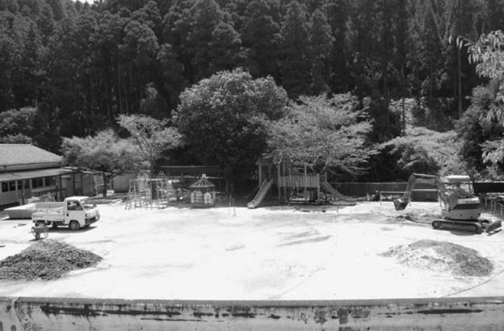
土砂を取り除く作業中の園庭
