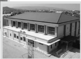
構造：鉄筋コンクリート造一部鉄骨造平屋建 面積：1032.65㎡
