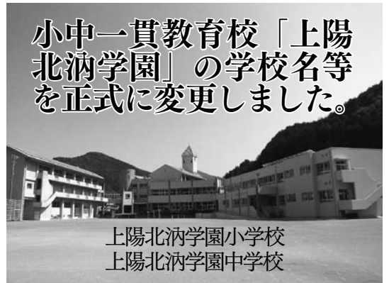
施設一体型の小中一貫教育校の校舎が完成しました。
