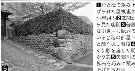
1 杉と松で組み上げられた屋根裏の小屋組み 2 玄関から見た客間 3 普段は引き戸に隠れている2階の部屋 4 と続く隠し階段 5 明かり窓 6 矢部川の転石を巧みに積み上げた玉石垣
