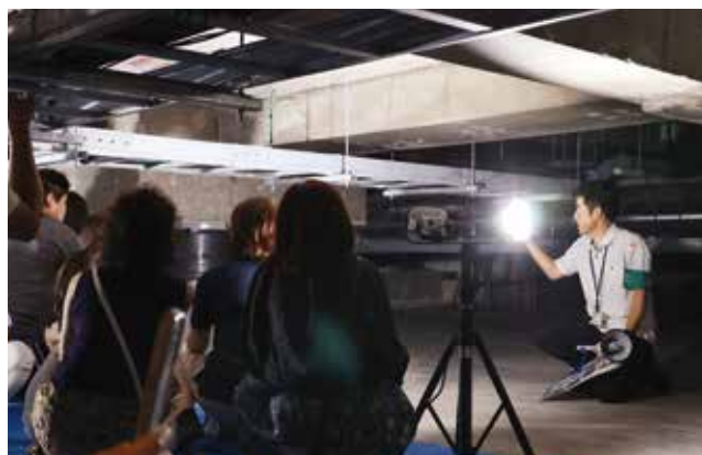
▲ 市役所地下の免震装置見学のようす
