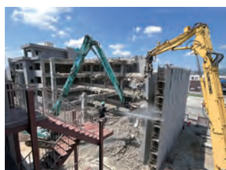
②旧庁舎(北庁舎)解体工事
