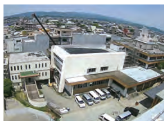
①旧庁舎解体前
