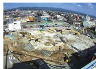
③旧庁舎解体完了
