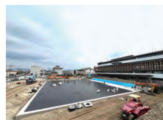
④雨水調整池(駐車場下)
