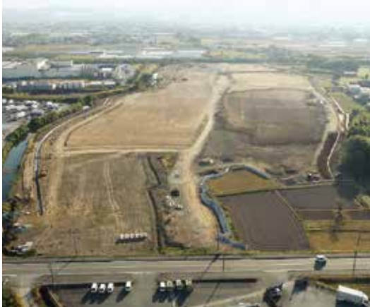
◀ 工場建設予定地
