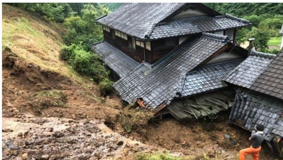
▲令和2年7月豪雨による被害状況（矢部地域）
