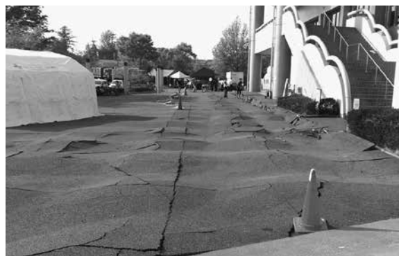
被災直後の益城町総合体育館。アスファルトがひび割れ、波打ち、震災のすさまじさを物語っています。
