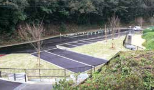
新たに整備された第三駐車場
