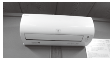
コミュニティ助成事業で整備されたエアコン
