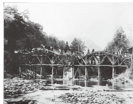
大正9年寄口橋の架設風景
