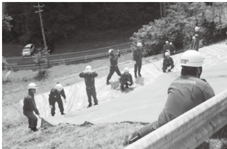
法面にシートを張る消防団員
