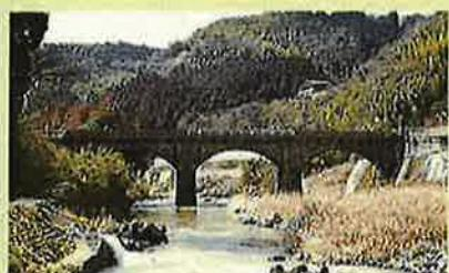
この橋は大瀬と轟間の星野川に架設された三連式アーチ型の石眼橋で、大正6(1917)5月3日に竣工している。石眼橋の長さは45.5m、幅は3.7m径間は12.0mである。
