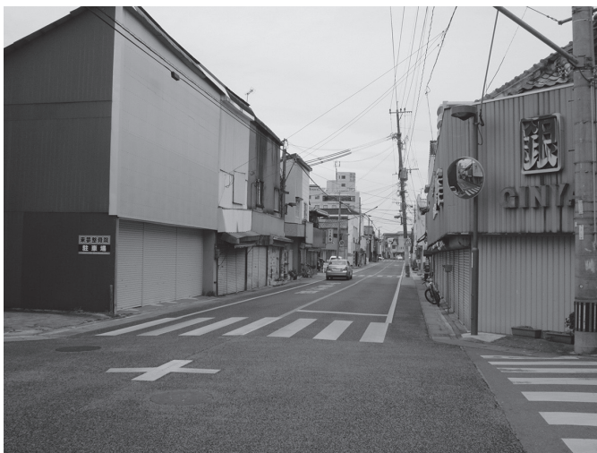
防犯カメラ設置予定の土橋商店街
